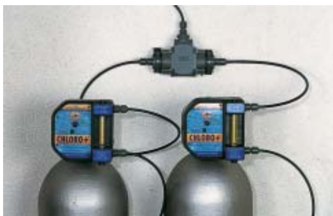
L'inverseur automatique type pneumatique, fonctionnant sans électricité et sans réarmement, convient pour des débits de chlore gazeux supérieurs à 200 g/h. Chaque chloromètre fonctionne à tour de rôle. Le réglage de débit se fait à distance sur un ou plusieurs débitmètres de chlore.
