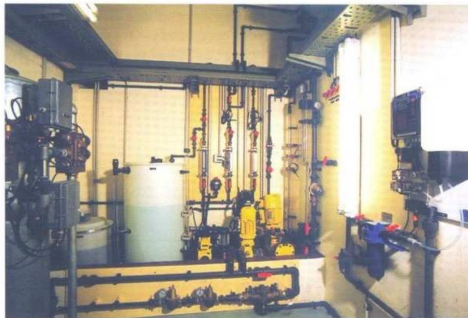
Figure 4 : Deux pompes doseuses, de capacité différente fonctionnant en cascade, assurent l'injection d'hypochlorite à 7,5 g/l
